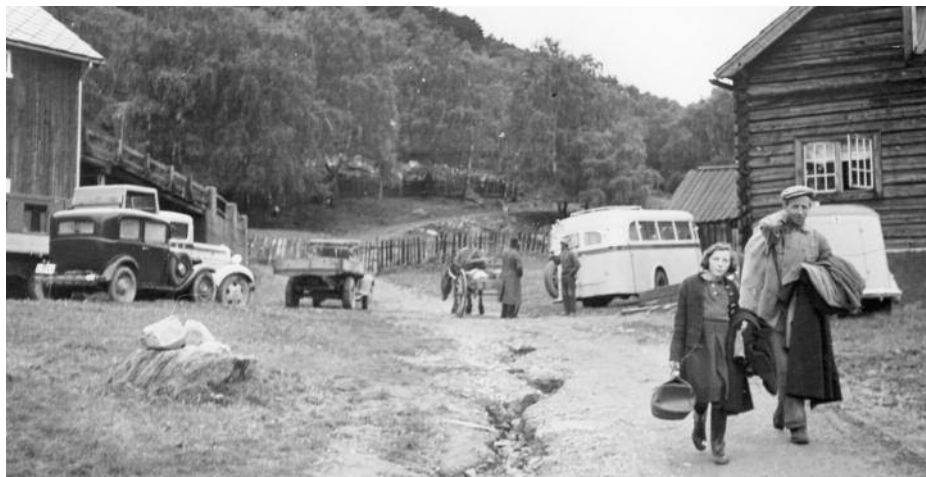
Øvre Nordheradsvegen gjekk gjennom prestgården. Anne og far Knut Rudistuen på tur heim etter overnatting i prestgården under flaumen 1938. Fotoutlån: Kjell Andersen.
