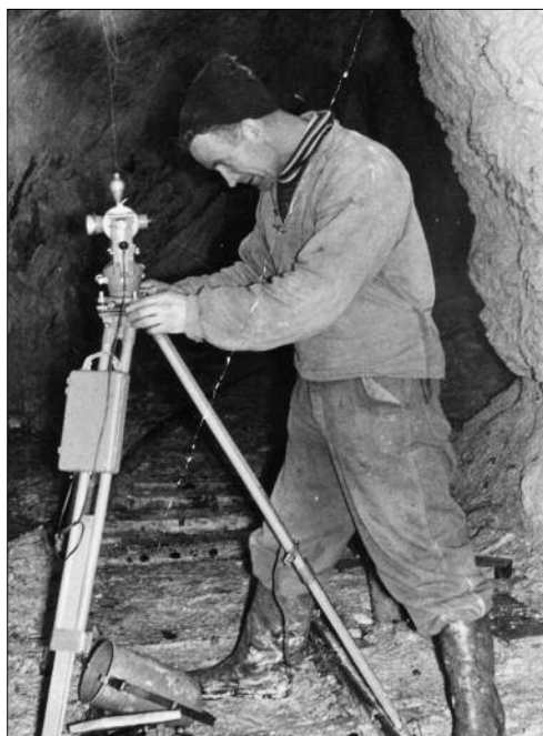
Arthur Bråten i tunnel på Bårstad ca. 1955. Utlån Reidunn Snerle.
