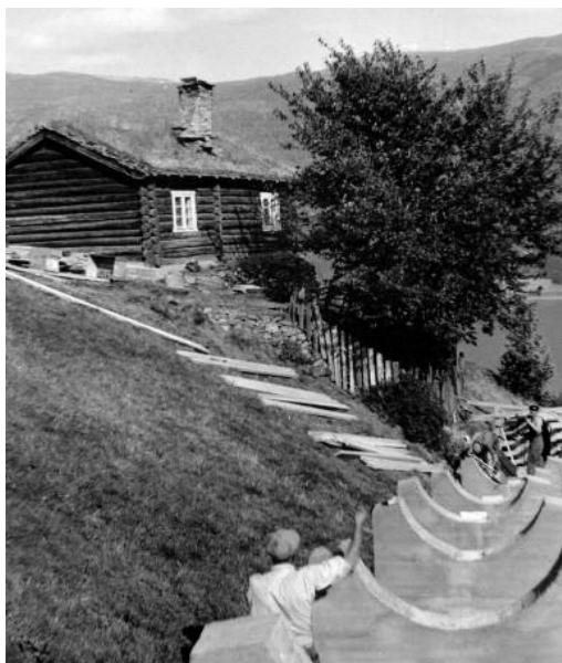
Frå kraftutbygging i Tessa, dette er vel frå ei seinare utbygging. Foto frå Terje Synslien.
