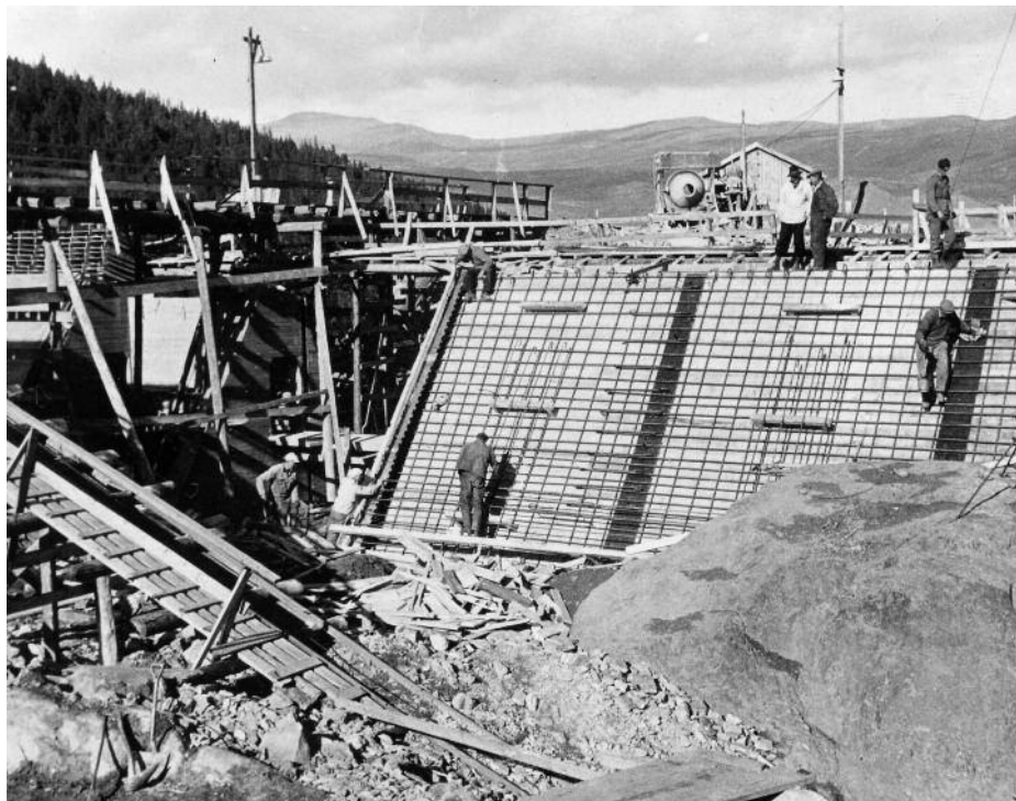
Frå legging av røyrgate ved Enden. Foto frå Ruth Bergdølmo.
